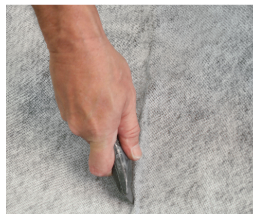
Couper la membrane pour éliminer les plis ou les objets coincés
