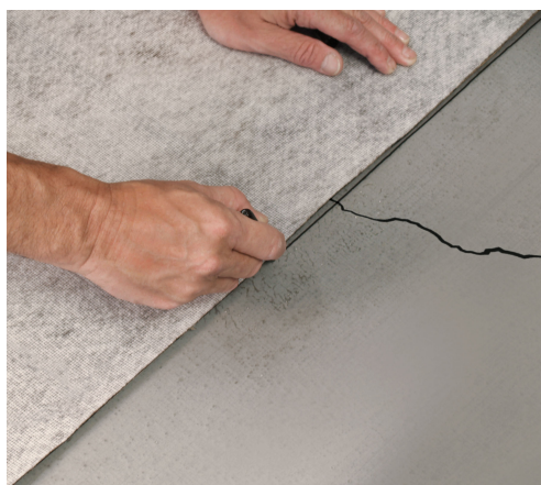
Installer à sec
