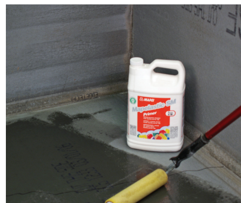
À l'aide d'un rouleau ou d'un pinceau, appliquer l'apprêt
