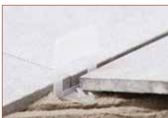
USO CON COLOCACION EN "+" TANTO EN EL CRUCE COMO EN LOS LATERALES
