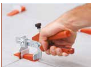
USO CON COLOCACION EN "T" EN EL CRUCE DE LAS BALDOSAS
