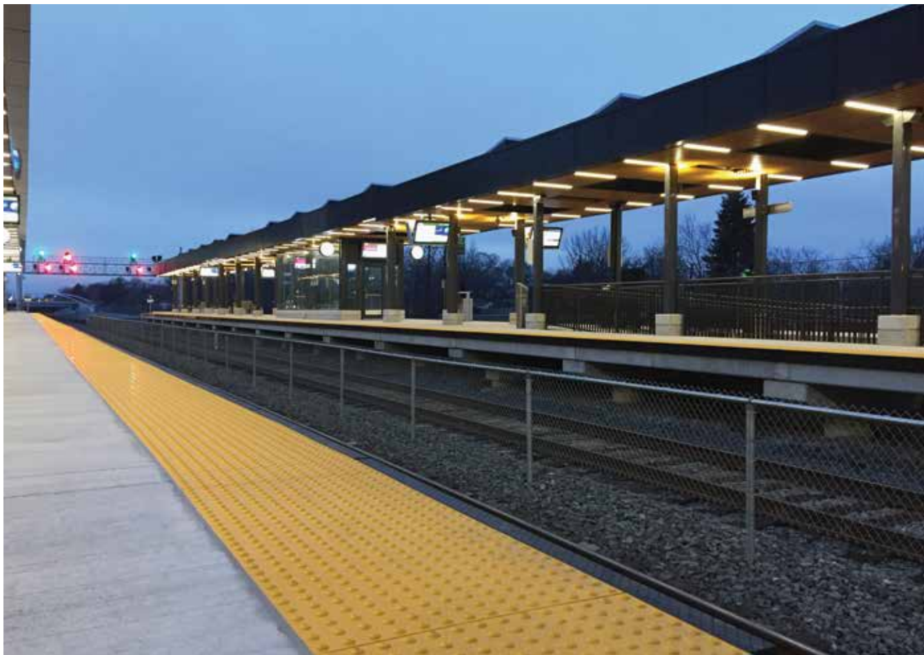
Bord de quai de la gare Weston avec pose de surface de transition Armor Tile MD .
