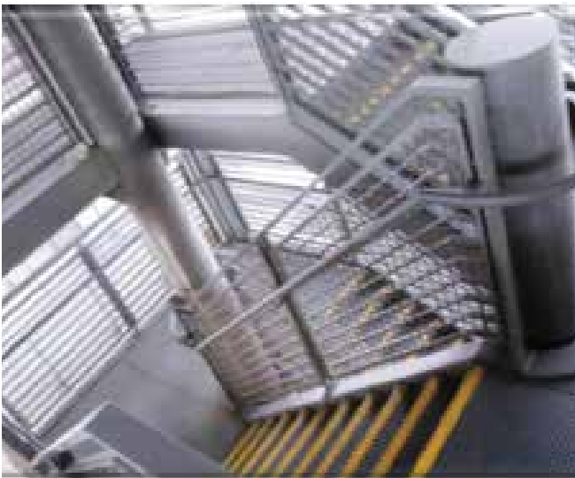
Un escalier en acier à nez de couleur contrastante offre un exemple de bon design. L'escalier aurait été encore plus accessible pour des personnes vivant avec une perte de vision si les mains courantes avaient été de couleur contrastante.
