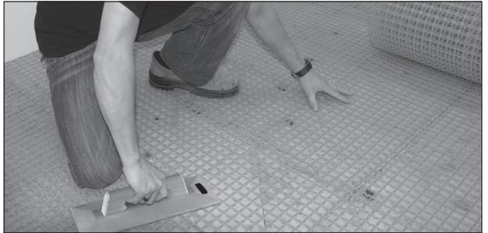
Comblir toute surface non couverte du FLEXSnap-R+ à l'aide de treillis FLEXSnap+ individuels. Une fois le plancher complètement couvert (y compris le plancher sous les meubles fixes), visser les treillis à chaque 30,5 cm (1 pi) dans les trous près des coins.
