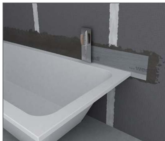
Illustration 4 : Raccord du bord de la baignoire à la couche d'étanchéité avec la bande d'étanchéité de baignoire en butyle wedi Tools.
