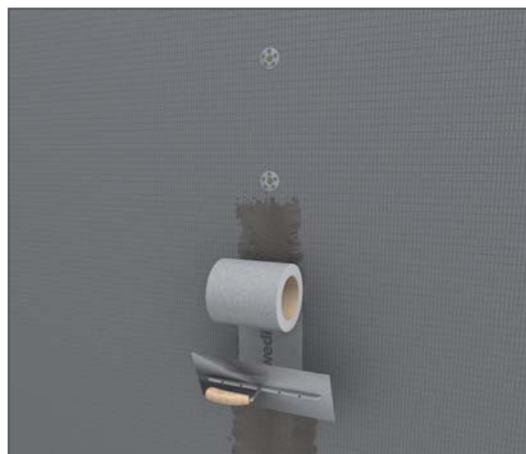
Illustration 8 : Étanchement de passages de tuyaux et joints avec la bande d'étanchéité wedi Tools
