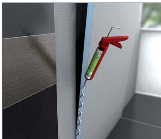
Illustration 10 : Étanchéité conforme au système avec la colle polymère wedi 610 dans W0-I et W1-I
