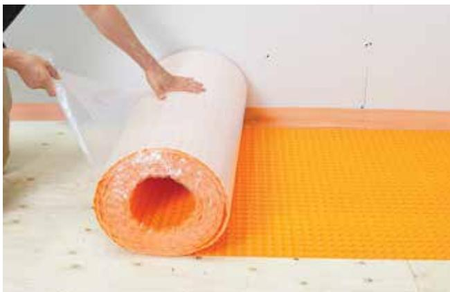
Il suffit de retirer la pellicule et de coller la membrane DITRA-HEAT-PS ou DITRA-HEAT-DUO-PS pour l'installer.
