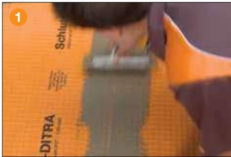
Remplissez, sur environ 8" (203 mm) au centre du joint, les cavités de ciment-colle Schluter SET®, Schluter ALL-SET®, Schluter FAST-SET® ou de ciment-colle non modifié.
