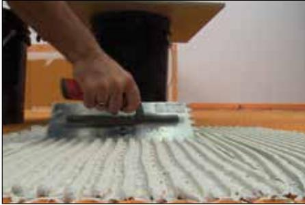
**1** Les carreaux peuvent être posés immédiatement sur les membranes DITRA-HEAT et DITRA-HEAT-DUO; nul besoin d'attendre que le ciment-colle durcisse. Remplissez les espaces de la membrane avec SET, ALL-SET, FAST-SET ou du ciment-colle non modifié, et étendez une autre couche de ciment-colle sur la membrane en utilisant une truelle adaptée au format des carreaux.
