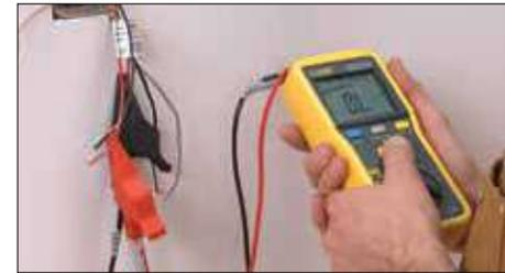
**7** Une fois l'installation des câbles chauffants et des capteurs thermiques au sol réalisée, reprenez les tests et consignez leurs résultats dans le registre de test du câble chauffant (page 37).
