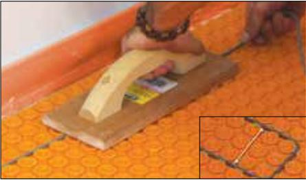
**4** Insérez les câbles chauffants entre les crampons, selon l'espacement déterminé à la section **Planification** de la page 19.
