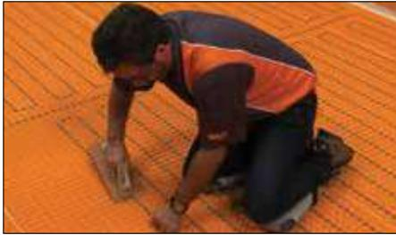
**5** Veillez à ne pas endommager les câbles durant la pose, particulièrement avant de les encastrer dans la membrane.
