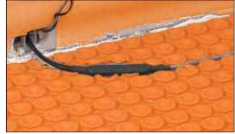
**3** Marquez l'endroit où se trouvera le raccord froid/chaud, coupez la membrane DITRA-HEAT ou DITRA-HEAT-DUO et le sous-plancher (si l'épaisseur du raccord l'exige), et insérez le raccord. Il pourra être nécessaire de coller temporairement le raccord au plancher à l'aide de ciment-colle ou d'un autre adhésif (ex. : KERDI-FIX ou colle chaude).
