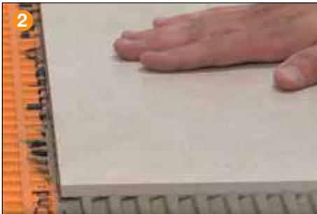
Encastrez les carreaux dans le ciment-colle, en effectuant un mouvement de va-et-vient perpendiculaire aux crêtes de ciment-colle. Vous écraserez ainsi les crêtes et améliorerez l'adhésion des carreaux. Assurez-vous de respecter le temps d'ouverture du produit. Si le ciment-colle forme une peau avant que les carreaux y soient déposés, retirez-le et appliquez-en une nouvelle couche.
