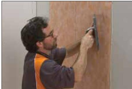
2 Appliquez Schluter SET®, ALL-SET®, FAST-SET®, ou du ciment-colle non modifié sur le substrat à l'aide d'une truelle à dents en V de 1/4" par 3/16" (6 mm x 5 mm) ou de la truelle KERDI-TROWEL. Encastrez la membrane KERDI ou KERDI-DS dans le ciment-colle sur toute la surface pour assurer une adhésion adéquate et retirer les poches d'air.
