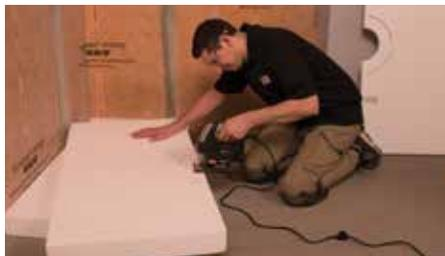
**2** Marquez le panneau de compensation et pratiquez-y l'ouverture pour la bride KERDI-DRAIN-H à l'aide du gabarit fourni (diamètre maximum de 5" [125 mm]). Réalisez une fente d'une largeur maximale de 2-3/4" (70 mm) à 3" (76 mm) pour le tuyau d'évacuation en ABS/PVC. Respectez ce maximum, de façon à assurer un soutien adéquat des carreaux.
