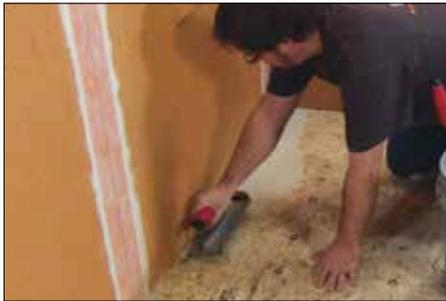
1 Appliquez Schluter SET®, ALL-SET®, FAST-SET®, ou du ciment-colle non modifié sur le substrat à l'aide d'une truelle dentelée à l'endroit destiné à recevoir le drain et encastrez-y le support de caniveau.
