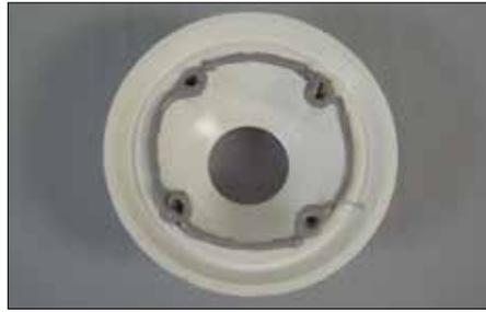
**2** Appliquez un cordon d'adhésif KERDI-FIX d'un quart à trois huitièmes de pouce (6 à 10 mm) sur la bride existante et placez-y l'anneau de l'adaptateur. Remettez les boulons en les serrant uniformément à la main, puis d'un quart de tour de plus. Évitez de trop serrer, car cela pourrait endommager l'adaptateur et provoquer des fuites.
