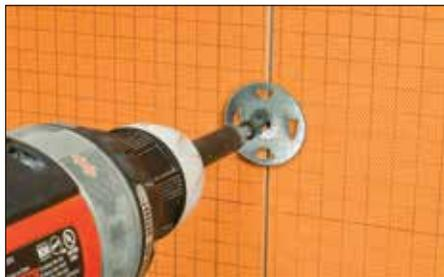
2 Placez les panneaux sur le centre des montants. Les vis peuvent être fixées entre les panneaux adjacents, de façon à ce que les rondelles chevauchent deux panneaux. Laissez un espace maximal de 12" (30 cm) entre le centre de chaque ancrage sur les murs et de 6" (15 cm) sur les plafonds. Rapprochez le plus possible de l'angle mural les rondelles posées dans les coins, le cas échéant.
