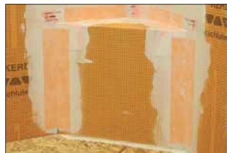
3 Posez les bandes KERDI-BAND et les coins KERDI-KERECK ou KERDI-KERS-B (pour le banc triangulaire) afin de recouvrir tous les raccords et coins, en assurant un chevauchement minimum de 2" (50 mm), puis collez la membrane dans le ciment-colle en vous assurant de réaliser une couverture complète et d'enlever les poches d'air.
