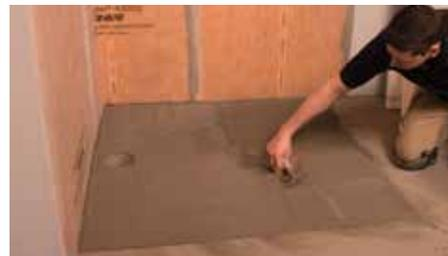
**3** Appliquez du ciment-colle Schluter SET®, ALL-SET®, FAST-SET® ou un ciment-colle non modifié sur le substrat à l'aide d'une truelle à dents carrées ou en U de 1/4" par 3/8" (6 mm x 10 mm).
