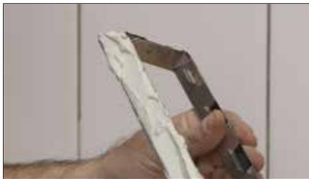
**1** Appliquez Schluter SET®, ALL-SET®, FAST-SET® ou du ciment-colle non modifié sur le dessous du cadre de la grille et placez-le sur le corps de caniveau, en vous assurant de réaliser une couverture et un soutien complets. Insérez les espaceurs en polystyrène dans le cadre de la grille pour le renforcer en vue des autres étapes de l'installation.
