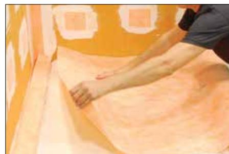
3 Aussitôt qu'on peut marcher sur le lit de mortier, le travail d'étanchéité peut commencer avec la membrane KERDI.
