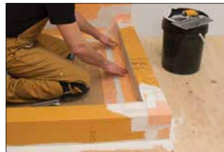
**4** On réalise les joints en superposant sur 2" (50 mm) les feuilles de membrane au moyen de SET®, ALL-SET®, FAST-SET® ou de ciment-colle non modifié, ou en disposant les feuilles côte à côte et en centrant sur les raccords des bandes d'étanchéité KERDI-BAND, puis en fixant le tout à l'aide de ciment-colle.
