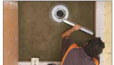
**2** La chape est étalée à égalité du dessus de la bride de collage du drain KERDI-DRAIN. Faites une pente dans le lit de mortier à 1/4" (6 mm) par 12" (305 mm) en utilisant le guide de nivellement au périmètre et la bride de collage.
