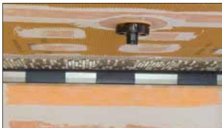
**2** Insérez les espaceurs dans le corps de caniveau. Installez les carreaux sur les murs voisins et la base de douche jusqu'aux espaceurs à l'aide de SET®, ALL-SET®, FAST-SET® ou du ciment-colle non modifié, en vous assurant de réaliser une couverture complète. Retirez tout excédent de ciment-colle.
