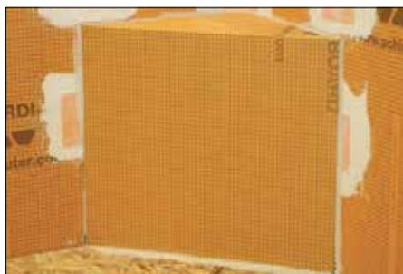
2 Encastrez bien le banc, et vérifiez en dessous et sur les côtés pour vous assurer que la couverture et le soutien sont complets. Assurez-vous que l'angle de la pente de l'assise du banc soit dirigé vers l'avant et non le mur.
