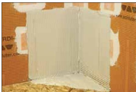
1 Appliquez une couche de Schluter SET®, ALL-SET®, FAST-SET® ou ciment-colle non modifié au plancher et sur le mur à l'aide d'une truelle à dents carrées ou en U de 1/4" par 3/8" (6 mm x 10 mm).
