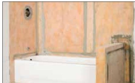
**8** Une fois la membrane posée, ainsi que les jonctions et les murs bas réalisés et donc imperméabilisés, l'assemblage est prêt à carrelage. Pour obtenir les instructions d'installation du carrelage, veuillez consulter la page 33.
