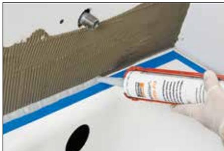
**2** Disposez du ruban à masquer pour protéger la baignoire. Appliquez Schluter SET®, ALL-SET®, FAST-SET® ou du ciment-colle non modifié sur le support solide à l'aide d'une truelle à dents en V de 1/4" x 3/16" (6 mm x 5 mm) ou de la truelle KERDI-TROWEL. Remplissez complètement l'espace de 1/4" (6 mm) entre le support solide et la baignoire d'adhésif KERDI-FIX ou d'un autre scellant approprié.
