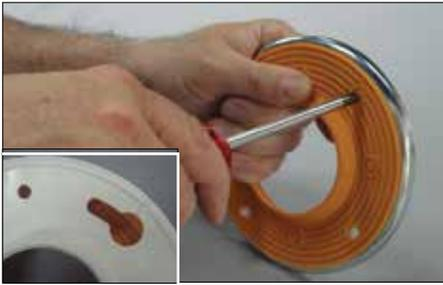
**1** Retirez l'anneau de serrage du drain déjà en place et conservez les boulons. Alignez les trous de l'anneau de serrage avec les trous prédécoupés de l'adaptateur et percez les trous à travers l'adaptateur.
