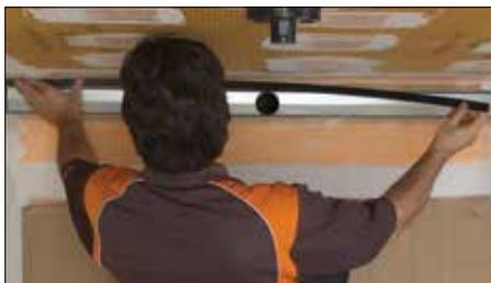
**1** Retirez la pellicule de protection de la bande de recouvrement et appliquez cette dernière sur la bride de collage le long du mur. Positionnez la bande le long du corps de caniveau. La bande de recouvrement servira à masquer et protéger la surface de KERDI sous les carreaux installés à l'étape 3.
