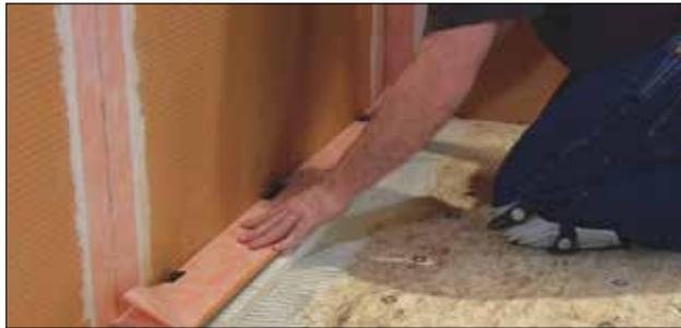
2 Appliquez SET®, ALL-SET®, FAST-SET®, ou du ciment-colle non modifié sur le dessus du support, puis enfoncez solidement le corps de caniveau, de façon à ce que la bride de collage repose entièrement dans le ciment-colle. Assurez-vous que le drain KERDI-LINE est de niveau.
