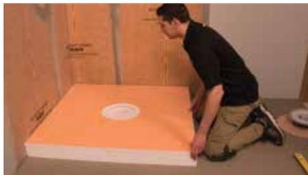
**1** Déposez en place sans les coller le panneau de compensation Schluter®-KERDI-SHOWER-CB et la base de douche KERDI-SHOWER. Si nécessaire, coupez la base et le panneau de compensation à la taille désirée. Prenez les mesures pour établir l'emplacement de la bride du drain et de la sortie en ABS/PVC.
