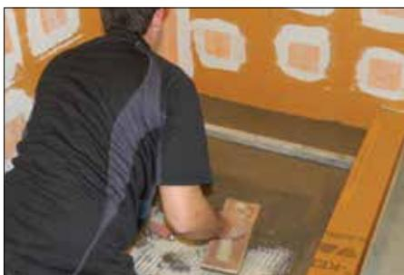
2 Remplissez de mortier le restant de la base de douche et faites une pente dans le lit de mortier à 1/4" (6 mm) par 12" (305 mm) en utilisant le guide de nivellement au périmètre et la bride de collage.
