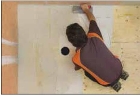
**1** Appliquez Schluter SET®, ALL-SET®, FAST-SET® ou du ciment-colle non modifié sur le substrat à l'aide d'une truelle à dents carrées ou en U de 1/4" par 3/8" (6 mm x 10 mm) **Remarque :** À cette étape, le ciment-colle étendu ne sert qu'à recevoir et soutenir la base.
