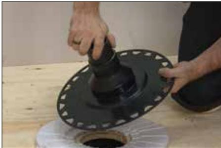
**1** Commencez en effectuant la pose à sec des composantes. Mesurez et coupez une section de tuyau qui servira à rattacher le drain KERDI-DRAIN au siphon en utilisant la section centrale détachable de la base de douche ou les espaceurs en polystyrène qui sont inclus avec le drain. Préparez le siphon, la section de tuyau et le drain KERDI-DRAIN au moyen de nettoyant, d'apprêt et de colle pour ABS ou PVC conformément aux instructions du fabricant, puis effectuez le raccordement.
