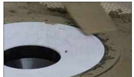
**2** Bourrez le mortier sous la bride de collage jusqu'à l'orifice, de façon à assurer le support adéquat et uniforme du drain, puis nivelez la surface. Formez ensuite le lit de mortier selon les instructions qui précèdent.
