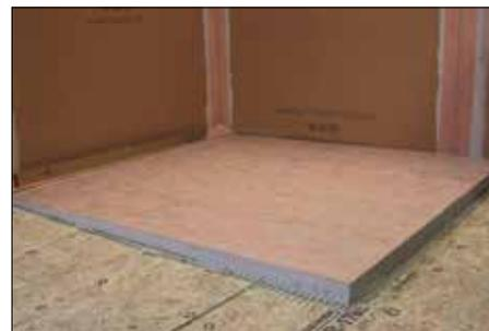
**Remarque :** Pour une installation centrée du caniveau KERDI-LINE (ex. : au centre d'une douche), il est recommandé de couper de façon égale aux extrémités les bases KERDI-SHOWER-LT pour que la première rangée de carreaux soit de hauteur uniforme. Pour une installation le long d'un mur, on réalisera la coupe sur la partie épaisse des bases KERDI-SHOWER-LTS, ce qui permettra une transition égale au niveau du drain.
