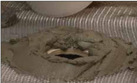
**1** Formez une couronne de mortier autour de l'orifice dans le plancher et pressez fermement le drain dans le mortier, puis nivelez la surface. La bride de collage doit être entièrement supportée pour prévenir les dommages à l'assemblage des carreaux (le coulis pourrait craquer autour du drain). Lorsqu'on pose le drain KERDI-DRAIN sur un substrat de bois, l'épaisseur minimale du mortier au périmètre de la bride de collage devra être de 1" (25 mm).
