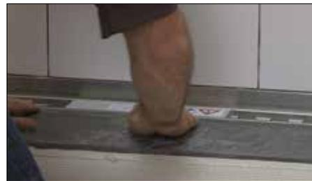
**3** Installez les carreaux sur la base de douche à l'aide de SET®, ALL-SET®, FAST-SET® ou ciment-colle non modifié, en vous assurant de réaliser une couverture complète. Apportez les derniers ajustements de façon à ce que le cadre de la grille arrive à égalité des carreaux voisins. Enlevez les espaceurs de carreaux en polystyrène et les espaceurs d'ajustement de hauteur en plastique à boulons filetés après le durcissement complet du ciment-colle (habituellement en 24 heures).
