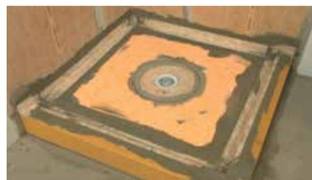
**9** Scellez les angles intérieurs en plaçant côte à côte les feuilles adjacentes et en posant les bandes KERDI-BAND, centrées sur le joint, à l'aide de ciment-colle Schluter SET®, ALL-SET®, FAST-SET® ou de ciment-colle non modifié. Posez des coins d'étanchéité préfabriqués KERDI-KERECK à tous les angles intérieurs et extérieurs. Avec KERDI-BOARD-SC, scellez le seuil à la base et aux murs au moyen des coins KERDI-KERECK et des bandes KERDI-BAND.
