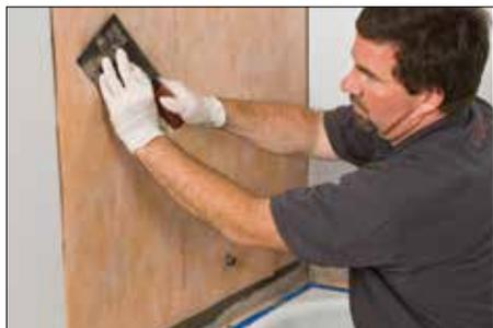
**4** Appliquez SET®, ALL-SET®, FAST-SET® ou du ciment-colle non modifié sur le support solide et les bandes KERDI-BAND posées au préalable. Encastrez la membrane KERDI dans le ciment-colle sur toute la surface pour assurer une adhésion adéquate et retirer les poches d'air.
