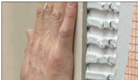
**2** Encastrez les carreaux dans le ciment-colle, en effectuant un mouvement de va-et-vient perpendiculaire aux crêtes de ciment-colle. Vous écraserez ainsi les crêtes et améliorerez l'adhésion des carreaux. Assurez-vous de respecter le temps d'ouverture du produit. Si le ciment-colle forme une peau avant que les carreaux y soient déposés, retirez-le et appliquez-en une nouvelle couche.
