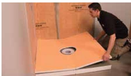
**7** Appliquez du ciment-colle Schluter SET®, ALL-SET®, FAST-SET® ou un ciment-colle non modifié sur le du panneau de compensation KERDI-SHOWER-CB à l'aide d'une truelle à dents carrées ou en U de 1/4" par 3/8" (6 mm x 10 mm). Assurez-vous que la base KERDI-SHOWER est solidement ancrée dans le ciment-colle.
