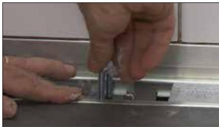
**2** Insérez les espaceurs d'ajustement de hauteur en plastique à boulons filetés dans les pattes le long de l'intérieur du cadre, de façon à pouvoir ajuster la hauteur de la grille, afin qu'elle arrive à l'égalité de la surface carrelée. Pour ce faire, il suffit de visser les boulons à la main.
