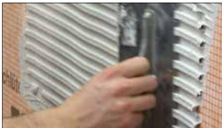
**1** Une fois les jonctions et coins complètement imperméabilisés, l'assemblage est prêt à carrelé. Appliquez une couche uniforme de ciment-colle SET®, ALL-SET®, FAST-SET® ou de ciment-colle non modifié, et étendez une autre couche de ciment-colle en utilisant une truelle adaptée au format des carreaux. Assurez-vous que les marques de truelle dans le ciment-colle vont dans le même sens, comme on le voit sur l'image ci-dessus.
