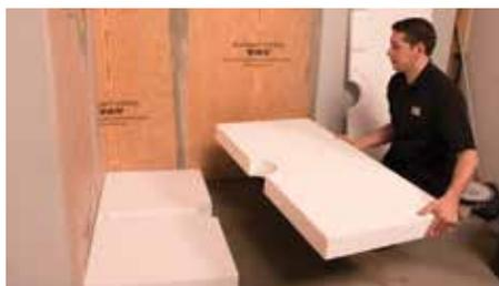
**4** Déposez le panneau de compensation KERDI-SHOWER-CB en vous assurant qu'il soit solidement ancré dans le ciment-colle.
