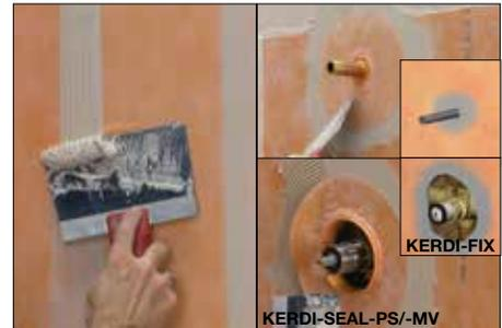
3 On réalise les joints en superposant sur 2" (50 mm) les feuilles de membrane ou en disposant les feuilles côte à côte et en centrant sur les raccords des bandes d'étanchéité KERDI-BAND. L'étanchéité de tout passage de tuyaux dans la membrane (valves, pomme de douche) doit être assurée au moyen des matériaux KERDI-SEAL-PS/-MV, KERDI-FIX ou d'un autre scellant adéquat.
