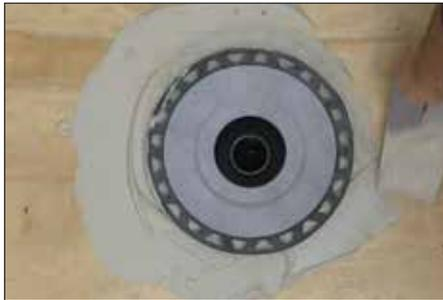
**2** Appliquez Schluter SET®, ALL-SET®, FAST-SET®, ou du ciment-colle non modifié sur le substrat et sur le dessus et le dessous de la section centrale préalablement retirée de la base de douche KERDI-SHOWER-T/-TS/-TT. Faites-la glisser sous la bride de façon à assurer un support adéquat et uniforme du drain.
