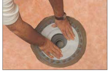
**3** Appliquez du ciment-colle de façon à remplir complètement la cavité de la base. Encastrez le drain KERDI-DRAIN dans le ciment-colle pour assurer le soutien complet de la bride de collage.
