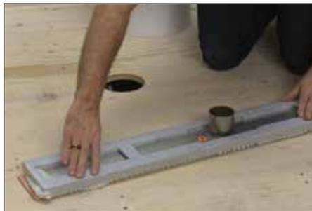
2 Appliquez SET®, ALL-SET®, FAST-SET® ou du ciment-colle non modifié sur le dessus du support à l'aide d'une truelle dentelée, puis enfoncez-le solidement sous le corps de caniveau. Fixez le raccord mécanique à la sortie et à la section de tuyau selon les instructions de fabricant.
