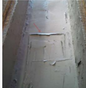
Lors de l'application sur des **revêtements existants**, des tests d'adhérence et de compatibilité sont recommandés et le revêtement existant déterminera l'adhérence et la performance des matériaux appliqués par la suite. Lors de l'application sur un revêtement existant, toute la surface doit être poncée afin de retirer le lustre. Si la surface n'est pas poncée, un décollement peut se produire en raison d'un manque d'adhérence.
