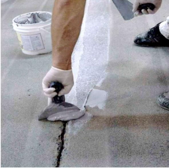
Toutes les fissures et les trous doivent être réparés avec un bouche-fentes avant l'application de l'enduit époxy. Le kit époxy pour garage CTM ne doit **PAS** être utilisé pour remplir des fissures ou des trous. Veillez à suivre les instructions du produit de remplissage de fissures choisi.
