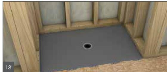
La douche Ligno affleure maintenant avec le sous-plancher environnant et s'appuie sur un sous-plancher doté d'une intégrité structurelle absolue, ce qui est essentiel pour une installation sûre des carreaux et sans risque de fissures du carrelage ou du coulis, qui peut être caractéristique des installations de substrats en carrelage ou des systèmes de douche installés avec un support insuffisant.
