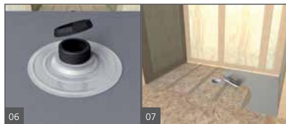
06 Serrer fermement les joints contre la bague en acier du receveur au moyen de l'écrou de verrouillage. Vérifier que le corps de l'écoulement est toujours bien inclus dans le cordon de joint de la vanne. Lisser l'excès de produit d'étanchéité sur la surface de la bride du corps de l'écoulement.
