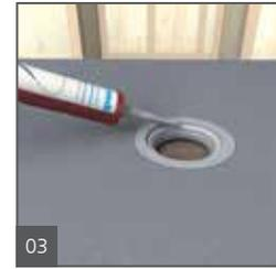
03 Tirer un cordon continu de 6,4 mm (1/4 po) de produit d'étanchéité wedi le long du profil rainuré supérieur de la vanne wedi Fundo. Il est possible aussi d'appliquer le cordon sur le dessous de la bride du corps de l'écoulement principal. Cela aidera à garder le produit d'étanchéité hors du filetage du corps de l'écoulement principal lors de son insertion.
