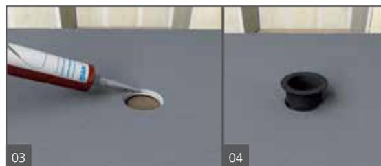
Tirer un cordon continu de 6,4 mm (1/4 po) de produit d'étanchéité wedi le long du profil rainuré supérieur de la vanne wedi Fundo. Il est possible aussi d'appliquer le cordon sur le dessous de la bride du corps de l'écoulement principal. Cela aidera à garder le produit d'étanchéité hors du filetage du corps de l'écoulement principal lors de son insertion.
