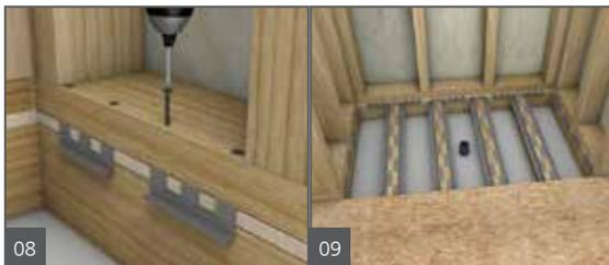
S'assurer que les supports en C sont montés de niveau (en supposant une plaque de base de niveau) et utiliser des vis autoperçuses à tête plate Phillips ailetées fournies par wedi. Fixer à travers la plaque de base et dans les deux (2) griffes métalliques reposant entre la plaque de base et le dessus du plancher en bois.
