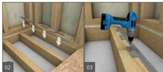
Couper les supports de solives à la longueur des solives de plancher exposées. En fonction de la longueur et de la direction des solives de plancher, il sera peut-être nécessaire d'ajouter un support de solive plus court. Ne pas utiliser de supports de solive plus courts que 304,8 mm (12 po) ou équipés de moins de deux brides de montage (au moins partielles).
