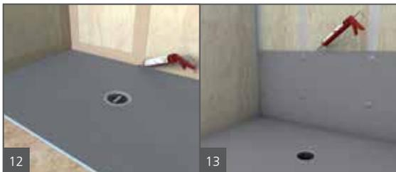
Tirer un cordon de 12,7 mm (1/2 po) de produit d'étanchéité wedi en suivant les rainures du périmètre extérieur du receveur mais seulement sur les zones dans lesquelles un panneau construction peut être posé immédiatement dans le produit d'étanchéité frais.
