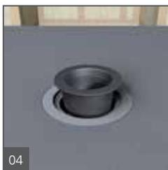
04 Plonger fermement le corps de l'écoulement dans le produit d'étanchéité.
