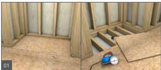
Mesurer et marquer le sous-plancher à enlever. Utiliser une scie de sécurité pour couper près de la charpente, mais aussi de manière propre et sûre. wedi recommande une combinaison de scies comprenant une scie sabre (Sawzall) et une scie telle que Dremel® US40 01 120 V là où une scie circulaire standard pourrait ne pas convenir.
