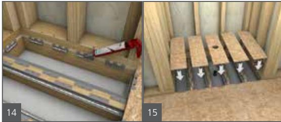
Nettoyer et dégraisser les surfaces des supports/brides et appliquer un cordon de produit d'étanchéité pour joint wedi de 6,35 mm (1/4 po). Utiliser du produit d'étanchéité wedi ou un adhésif de construction approprié pour les applications sur métal et bois.
