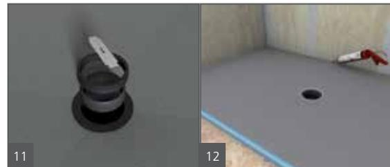
Serrer (pincer) fermement le joint d'étanchéité en caoutchouc avec l'écrou de calfeutrage (utiliser un tournevis à tête plate) et finalement installer le châssis en plastique et la grille par-dessus (sans adhésif). Le châssis et la grille seront tenus par un joint en coulis un fois que le carrelage débute. Ne pas serrer le joint avant 60 minutes après que la partie filetée de l'écoulement a été scellée dans la base de la douche.
