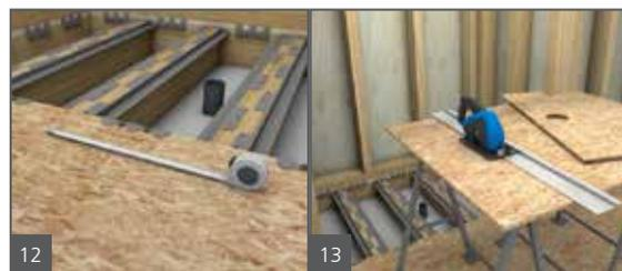
Mesurer et marquer pour couper des lames de bois bien ajustées dans le système de support encastré entre les solives, la charpente murale et le sous-plancher normal. Laisser un espace de 3,2 mm (1/8 po) entre les lames de bois et les supports afin que le bois puisse bouger sans créer de tension excessive.
