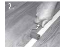
2. Adhere tape with small rubber hand roller. Pressez le ruban masquant à l'aide d'un petit rouleau. (caoutchouc) Adhiera la cinta adhesiva con un rodillo pequeño de mano. (de goma)
