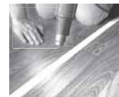
4. Heat the seam area. Chauffez le joint. Caliente el área de la junta.
