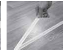
6. Remove the masking tape after appropriate drying time. Enlevez le ruban masquant après la période de séchage appropriée. Remueva la cinta adhesiva protectora después del tiempo apropiado para secarse.
