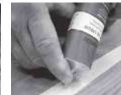
5. Apply the cold weld liquid. Appliquez le liquide de soudure à froid. Aplique el líquido sellador.
