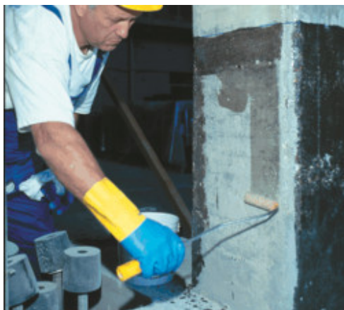
Applying MapeWrap Primer 1
