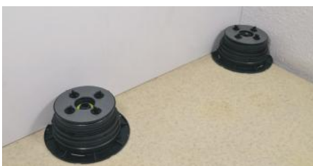
2. Coloque los soportes contra la pared.
