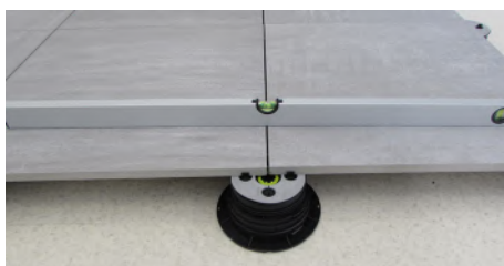
16. Verifique que el pavimento sea lineal.
