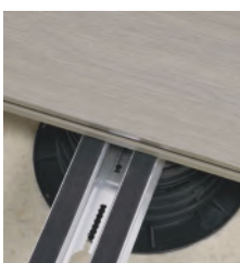
8. Verlegen Sie die Holzleiste, indem Sie den Schlitz in den Abstandhalter stecken.
