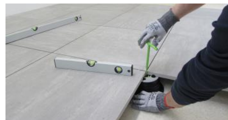
17. Im Falle einer Abweichung die Höhe mit dem Schlüssel SUPAK nachjustieren.
