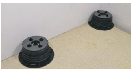
2. Positionieren Sie die Stelzlager an der Wand.
