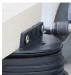
13. Den Balken am Träger mit den vorgesehenen Schlitzte anschrauben.
