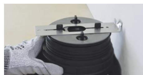
9. Den Randabstandshalter SUPACLPP zwischen den Abstandshaltern des Stützlagers und mit Kontakt zur Wand anbringen.
