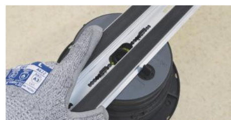
3. Introducir la vigueta SUPAANG entre las aletas de los soportes.
