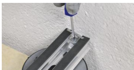
7. Befestigen Sie den Abstandhalter am Stelzlager.
