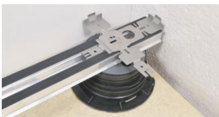
5. Esquina - Coloque los clips espaciadores SUPACLPT perpendiculares y paralelos a la vigueta y en contacto con la pared.
