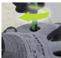
10. Rimuovere le altre due alette con la chiave SUPAK.
