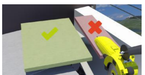
9. Die Fliese zuschneiden.
