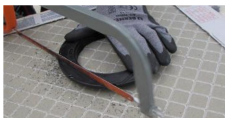
7. Capovolgere la base e rimuovere uno dei lati lungo la linea pre-incisa.
