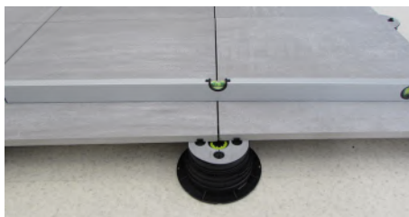
16. Verificare che il pavimento sia planare.
