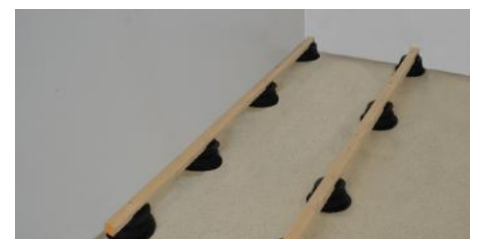
14. Überprüfen, dass der Balken fest mit jedem Träger verbunden ist.
