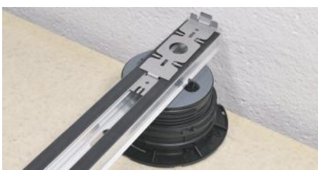
8. Coloque la siguiente vigueta separada de la pared con el clip SUPACLPT.
