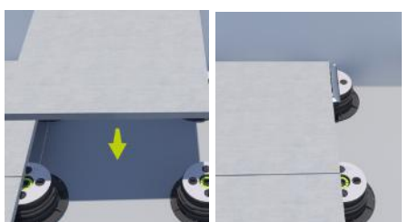
7. Posare le piastrelle.
