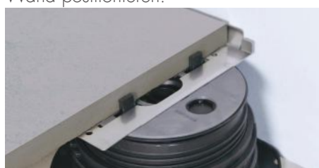
11. Die Platte verlegen.
