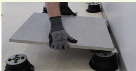
13. Die Platte verlegen.
