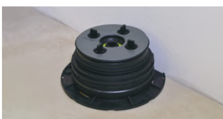
8. Das Stützlager zusammenbauen und mit der abgeschnittenen Seite an der Wand positionieren.
