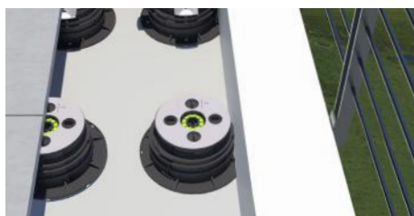
14. Den Träger mit der abgeschnittenen Seite in Berührung mit der Wand positionieren.
