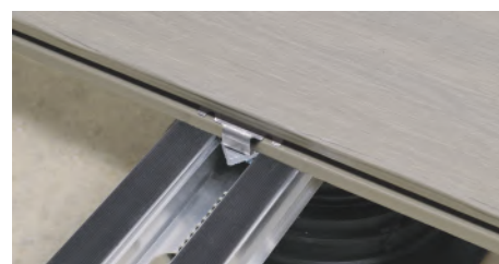
9. Einen Clip SUPCLIPG zur Blockierung der Dielen positionieren.
