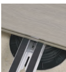
8. Posez le listel en bois en enclenchant sa fente dans le clip.
