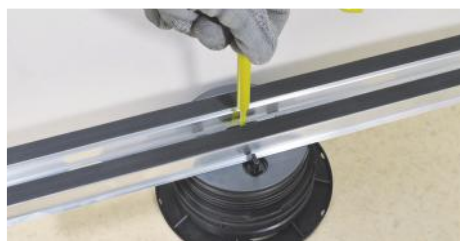
4. Nivellieren Sie die Stelzlager mit dem SUPAK-Einstellschlüssel, um eine ebene Oberfläche zu erhalten.
