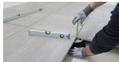
17. In caso di disallineamento, aggiustare l'altezza tramite la chiave SUPAK.
