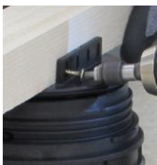
13. Den Balken am Träger mit den vorgesehenen Schlitzte anschrauben.
