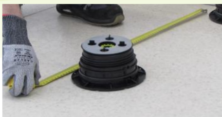
12. Distanziare i centri dei supporti pari alla dimensione della piastrella. Interasse massimo: 60 cm
