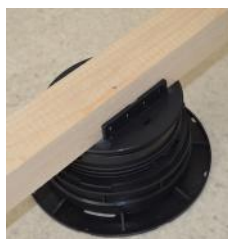
12. Den Holzbalken, der auf dem Flügel SUPAVV aufliegt, positionieren.
