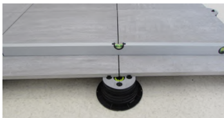
16. Überprüfen, ob der Bodenbelag gerade ist.
