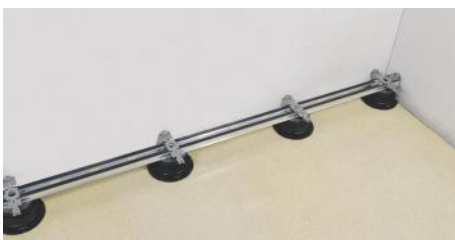
7. Die restlichen Stelzlager positionieren.
