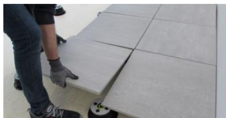
15. Die anderen Platten positionieren.
