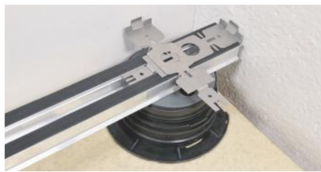
5. Ecke - Positionieren Sie den SUPACLPT-Abstandshalter senkrecht und parallel zum Profil und in Kontakt mit der Wand.
