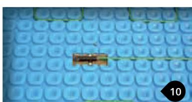
Pour terminer l'installation du câble, couper la membrane pour y insérer la terminaison.
