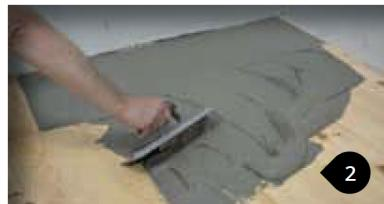
Étendre le ciment-colle approprié sur le sous-plancher avec le côté plat de la truelle pour le faire pénétrer dans le support
