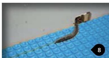
Pour débuter l'installation du Câble FLEXDECO, couper la membrane pour y insérer le joint mécanique et la partie de la liaison froide nécessaire.
