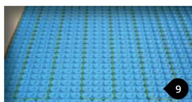
Installer le câble selon le guide d'installation en s'assurant d'insérer le câble à un espace uniforme aux 3 crampes et à une puissance maximale de 11,5 watts/pied carré.
