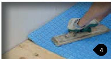
Dérouler la membrane sur le ciment-colle et appliquer une pression uniforme sur celle-ci à l'aide d'une truelle de bois.
