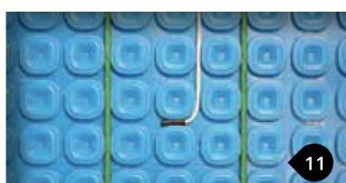
Installer la sonde de plancher entre 2 passes de câble.
